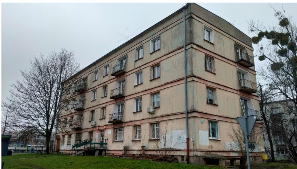
Photo 1. Bâtiment à usage résidentiel à Lodz, comprenant une institution de santé publique au rez-de-chaussée.
