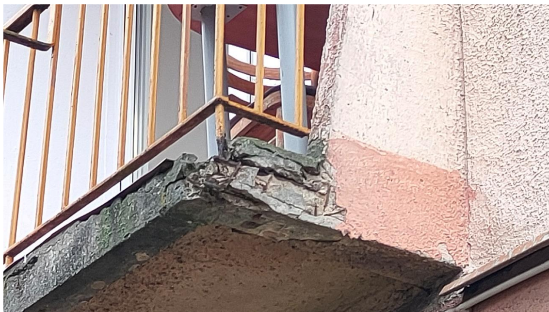
Photo 6. Balcons présentant des fissures et des décollements ainsi que du fer d'armature exposé et rouillé
